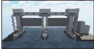
※水門の自動化：津波警報等が発表され、衛星からJアラートにて情報を受信した際に水門を自動閉鎖。
