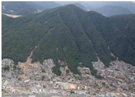
平成26年8月豪雨 (広島県広島市)
