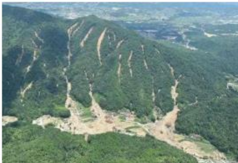
平成30年7月豪雨 (広島県呉市)
