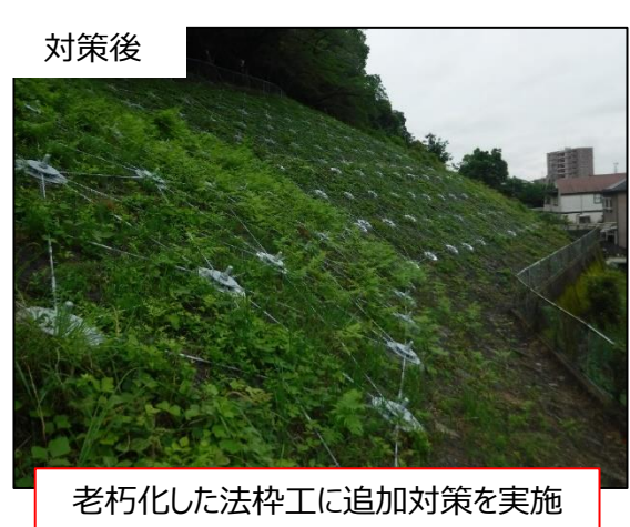
急傾斜地崩壊防止施設の補修 (御殿山地区・枚方市)
