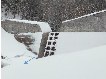
透過型堰堤 北川（能勢町）
