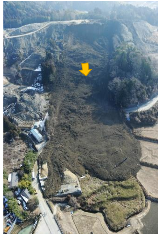
土砂崩落直後
