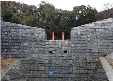
部分透過型堰堤 鬼虎川（東大阪市）
