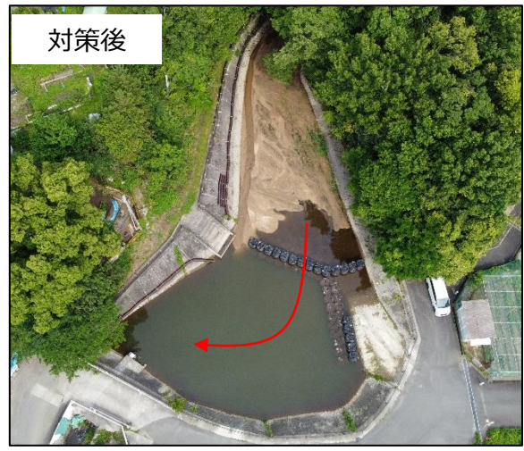
砂溜工の除石 (鳴川・東大阪市)
