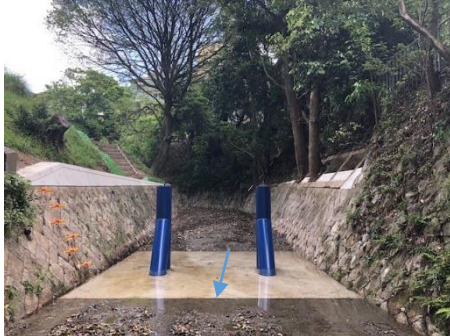
流木捕捉工の増設 オケ原川（箕面市）
