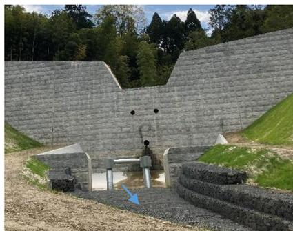
不透過型堰堤+流木捕捉工
