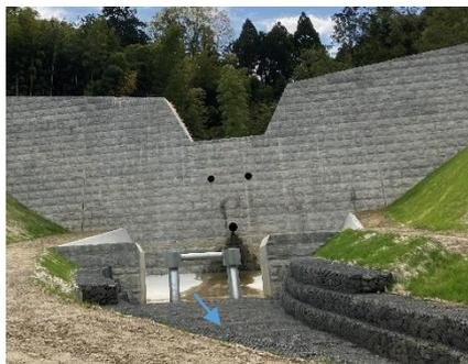
不透過型堰堤 + 流木捕捉工
