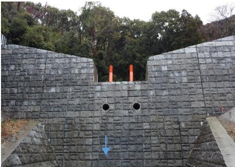
部分透過型堰堤 鬼虎川（東大阪市）
