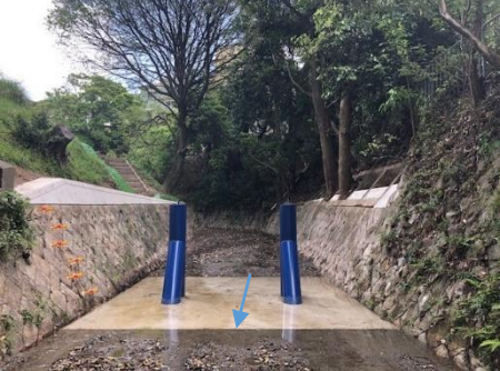
流木捕捉工の増設 オケ原川（箕面市）
