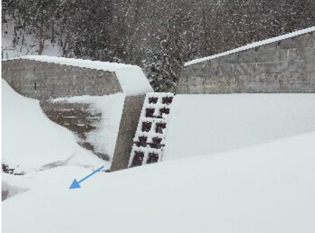
透過型堰堤 北川（能勢町）
