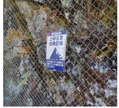
土砂災害警戒区域の現地表示（箕面市）
