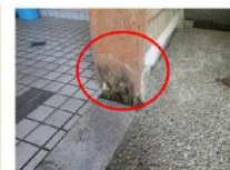
【大鷲トイレ（近畿自然歩道）】 柱の下部及び壁構造部が老朽化により腐朽している状況
