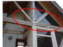
【なるかわ園地（広場）トイレ】 炭が老朽化により腐朽している状況
