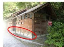
【大鷲トイレ（近畿自然歩道）】 柱の下部及び壁構造部が老朽化により腐朽している状況
