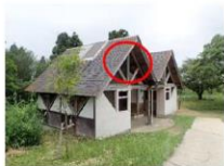
【なるかわ園地（広場）トイレ】 炭が老朽化により腐朽している状況
