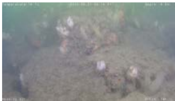
図 5.4.1-4 被覆石上への浮泥の堆積
