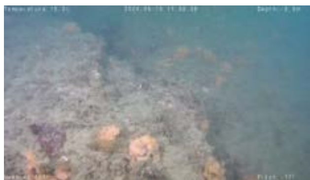
図 5.4.5-4 被覆石上への砂泥の堆積
