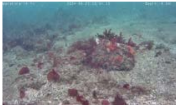
図 5.4.2-4 被覆石上への砂泥の堆積
