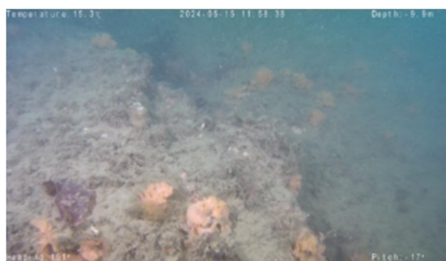
図 5.4.5-4 被覆石上への砂泥の堆積
