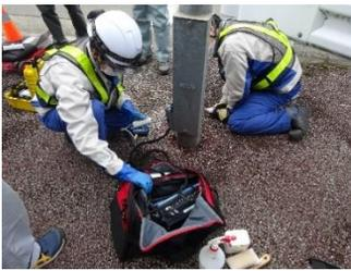
照明柱の非破壊調査
