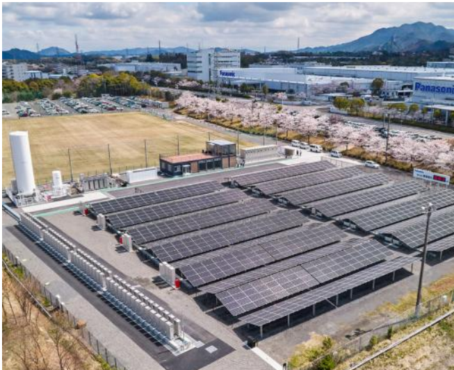
燃料電池(水素)、太陽電池、蓄電池、エネルギー管理システム(EMS)
