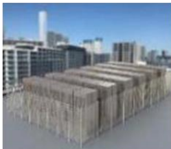
屋上設置 300kW
