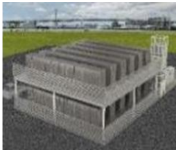
発電施設 1MW
