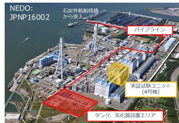
IHIは、JERAおよびNEDO（国立研究開発法人新エネルギー・産業技術総合開発機構）とともに、NEDOの助成事業である「カーボンサイクル・次世代火力発電等技術開発／アンモニア混焼火力発電技術研究開発・実証事業」に取り組んでいる。本事業にて、IHIとJERAは、世界初となる大型石炭火力発電機における燃料アンモニアの大規模転換実証試験（熱量比20%）を実施した。
