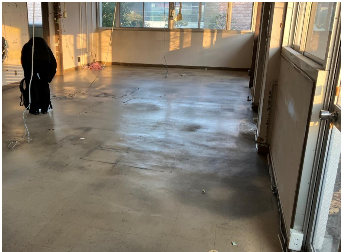
④ 施設 内 写 真 (1)
