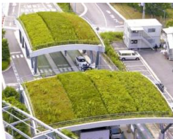
計量棟の屋上緑化
