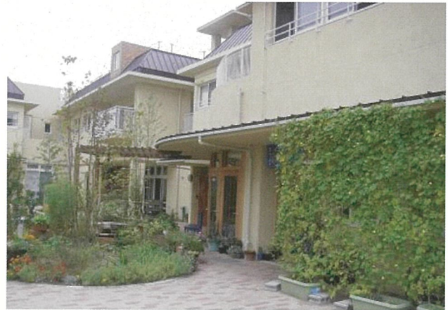
多様な植物により緑化された施設中庭
