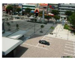
透水性・保水性舗装
