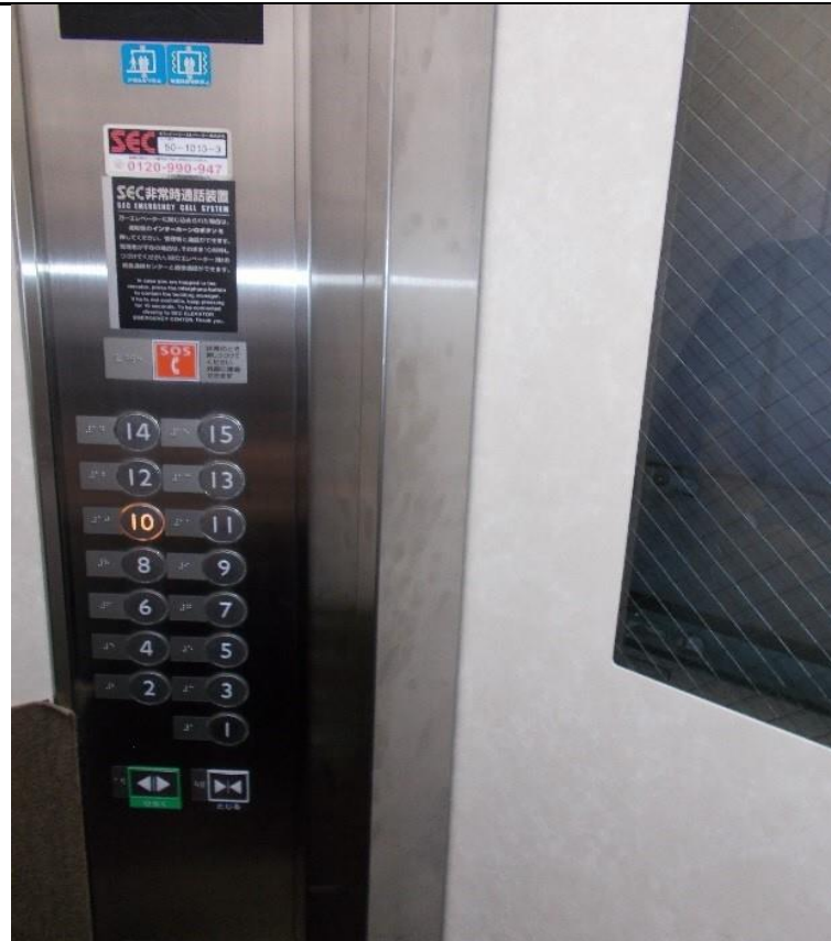
エレベーター（内側から撮影）
