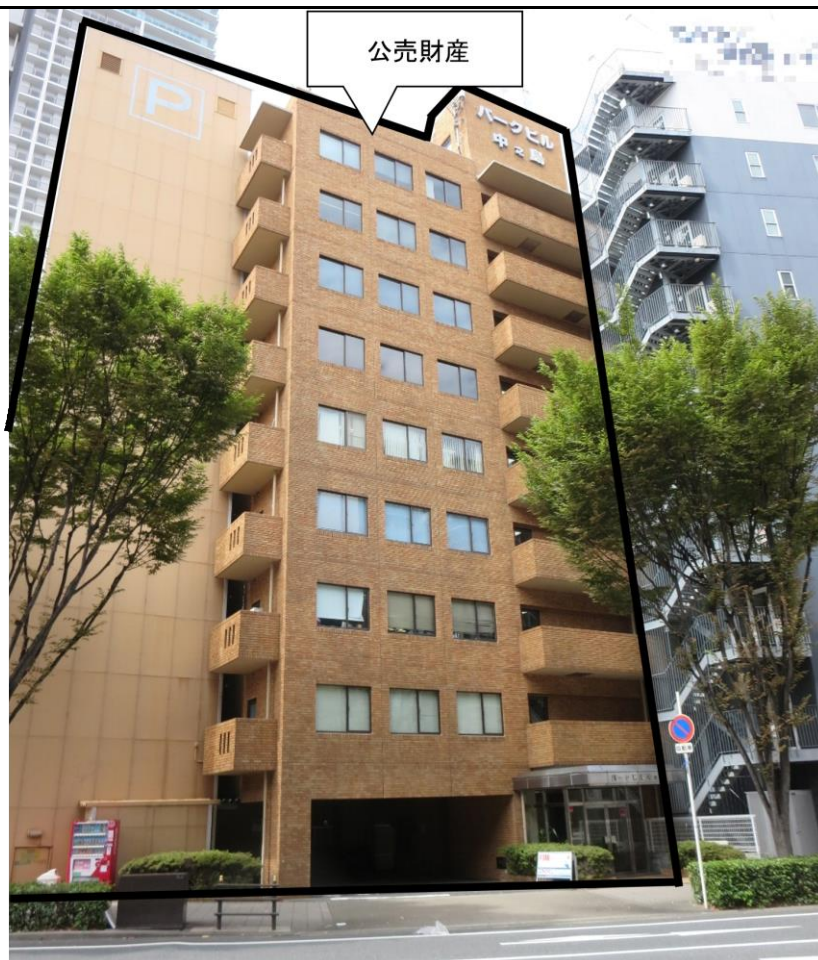
北東側から撮影
