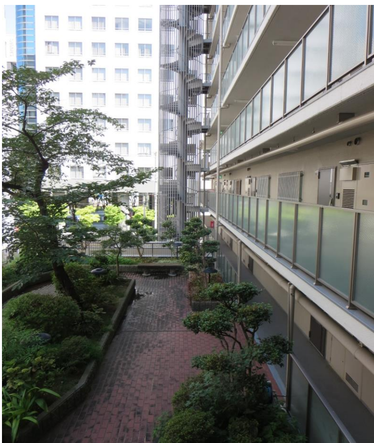
3階通路から屋上庭園を撮影
