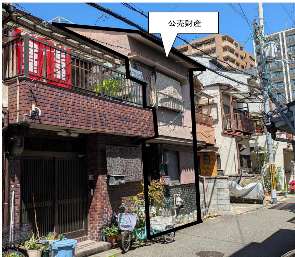
南東側から撮影
