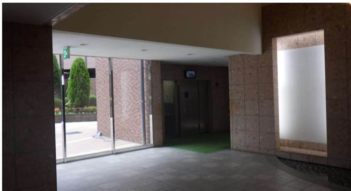
1階エレベータ前(共用部)
