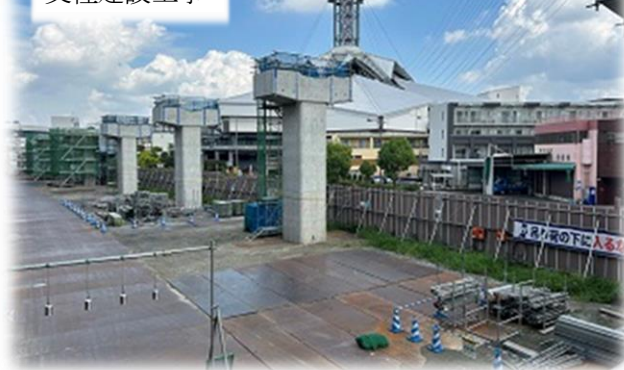
支柱建設工事
