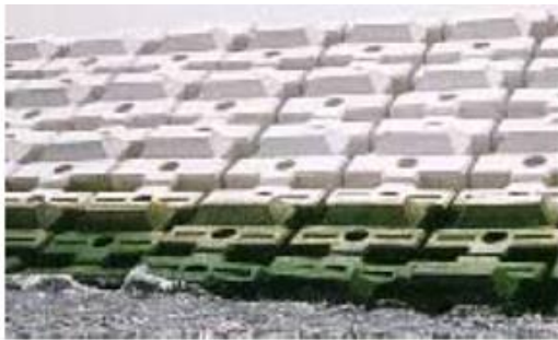
図4 大阪沖埋立処分場の緩傾斜護岸
