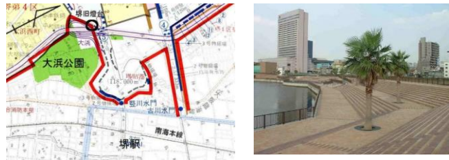
図14 堺旧港における親水護岸の整備
