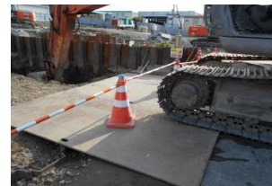
汚染土壌掘削工事の現地 確認状況
