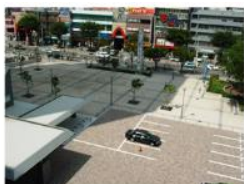
透水性・保水性舗装
