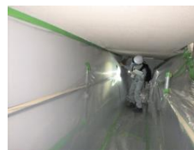
解体現場の立入調査
