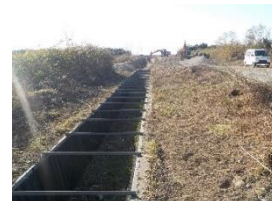
堺第7-3区での排水路改修工事
