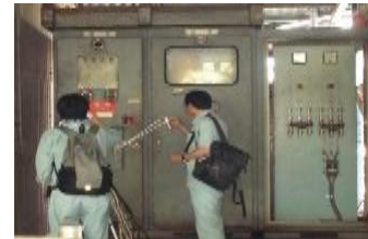
PCB廃棄物に係る立入検査
