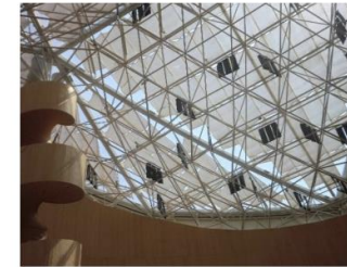
大阪ヘルスケアパビリオンでのペロブスカイト太陽電池の設置状況
