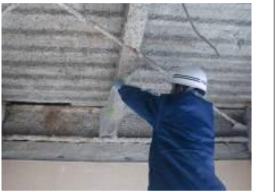
解体現場立入検査
