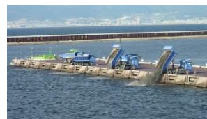
フェニックス処分場 における廃棄物受入
