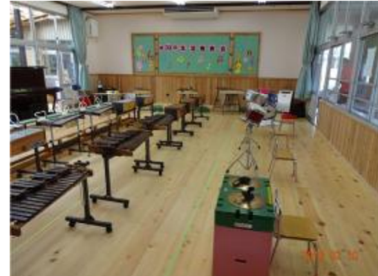
多目的室の床・腰壁の木質化
