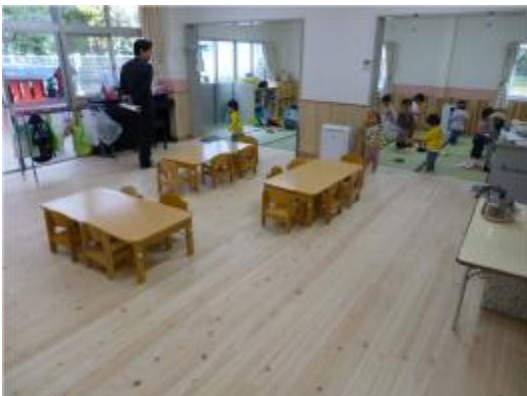
保育室の床・腰壁の木質化
