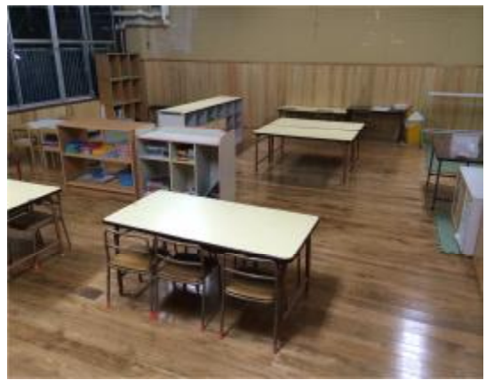
保育室の床の木質化
