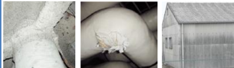
吹付け石綿 石綿含有保温材 石綿含有成形板
