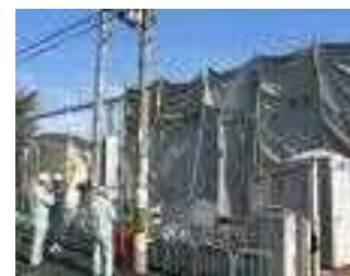
アスベスト解体現場パトロール
