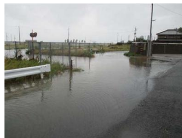
漁港移管に向けた問題点の確認 (例：深日漁港における浸水)
