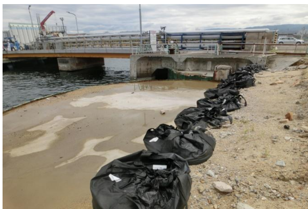
写真－５ 護岸補修予定箇所(施工前)
