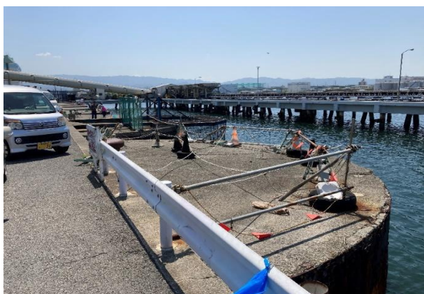
写真－2 護岸補修予定箇所(施工前)
