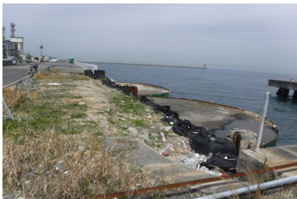
写真－４ 護岸補修予定箇所(施工前)
