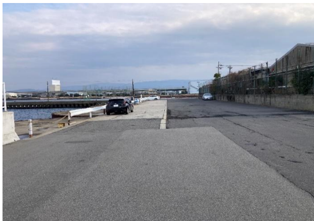
写真－2 舗装補修予定箇所(施工前)
