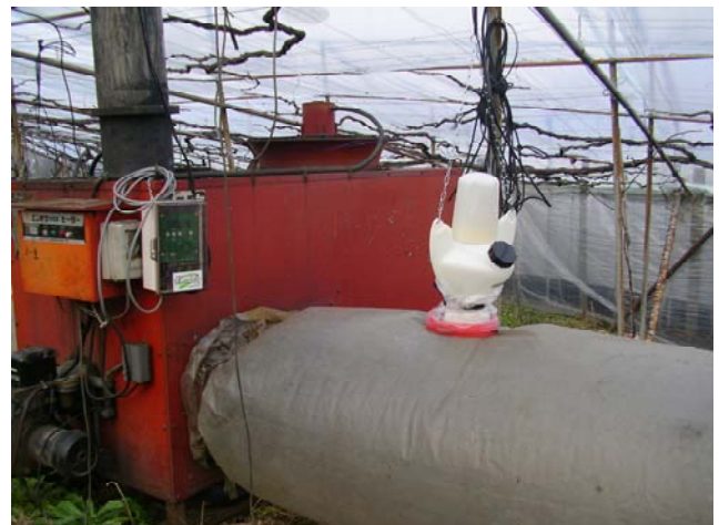
▲ ダクト内投入によるボトキラー水和剤の散布
