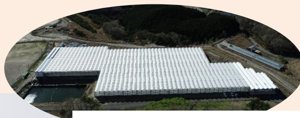
▲ドローン撮影によるハウス全景
