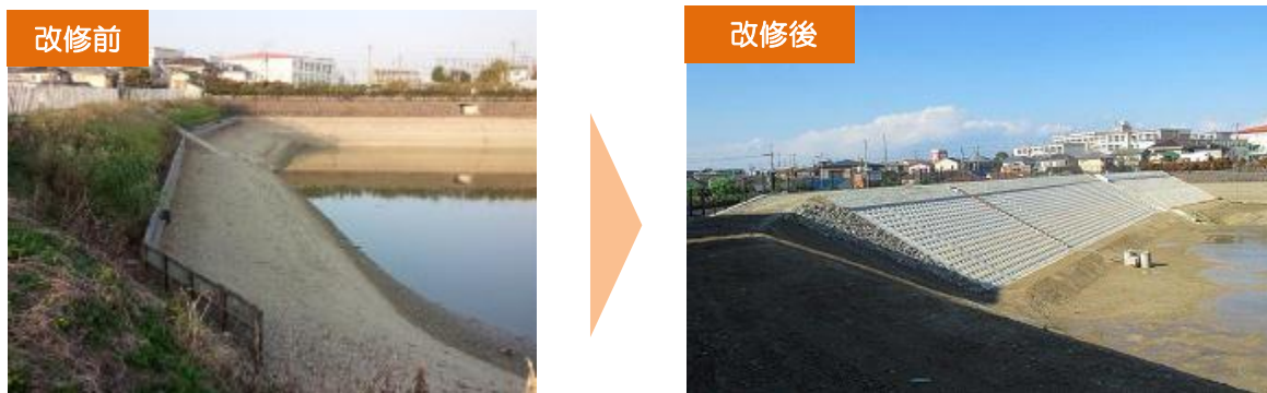
老朽ため池改修
