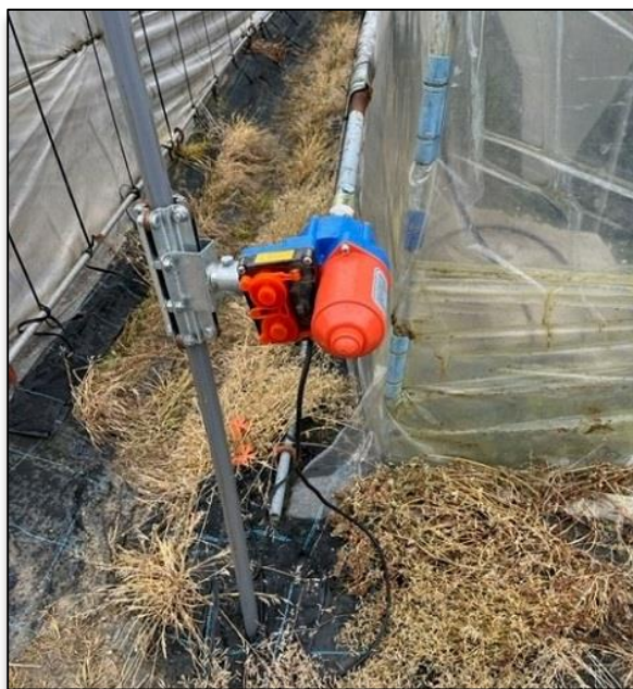
自動開閉装置
