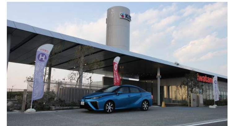
位于关西国际机场的Iwatani 氢气站 (2016年1月起开始营业)
