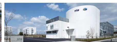
先端技術評価実験棟 (MIDDLE Chamber)
