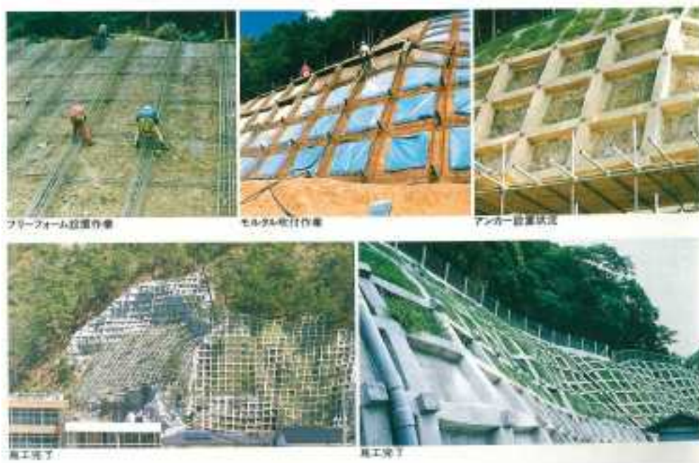
図 5.23 のり枠工の施工 (植生工とアンカー工の併用)
