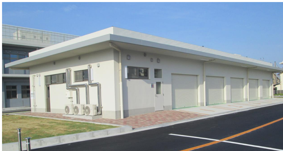
【大阪府計量検定所 タクシーメーター検査場棟改築工事】
