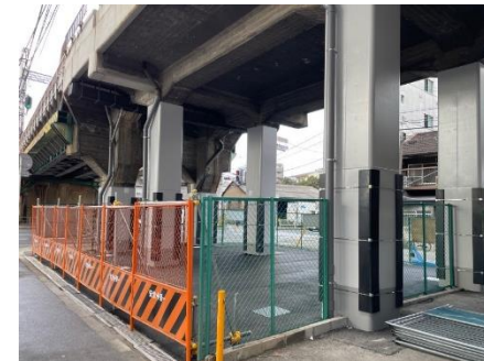
写真1：鉄道耐震補強状況（阪神本線）
