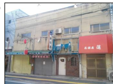
老朽建築物除却前
