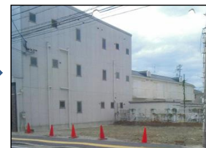
老朽建築物除却後
