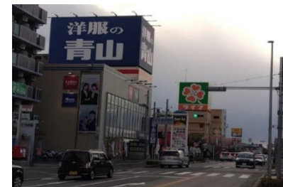
写真4：府道大阪港八尾線（抜柱後）（八尾市）
