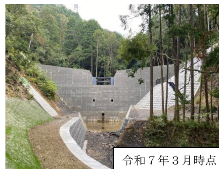
写真5：楠畑川第1支溪砂防堰堤
