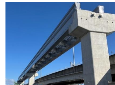
写真7：大阪モノレール延伸事業
