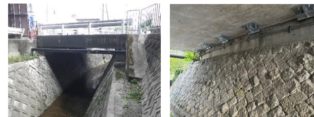
（全景）（落橋防止装置の設置） 写真5：国道423号 砂小谷小橋1（上）
