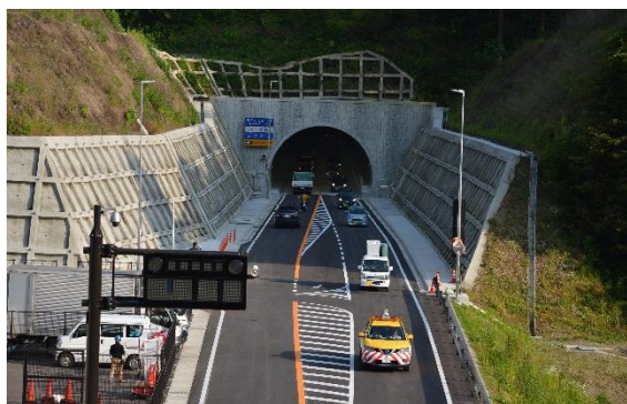
写真 1：国道 371 号（石仏バイパス）（河内長野市）
