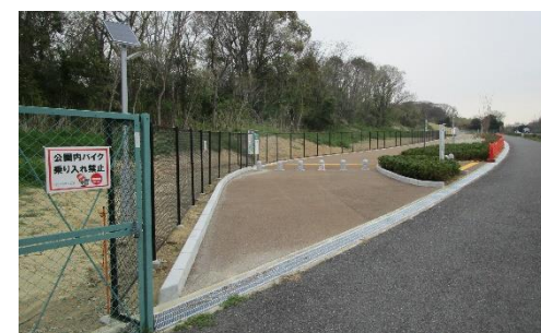
写真1：防災公園の拡張整備（蜻蛉池公園）
