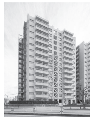
【耐震改修事業 （油圧式制振ブレース工法）】 堺戎島住宅
