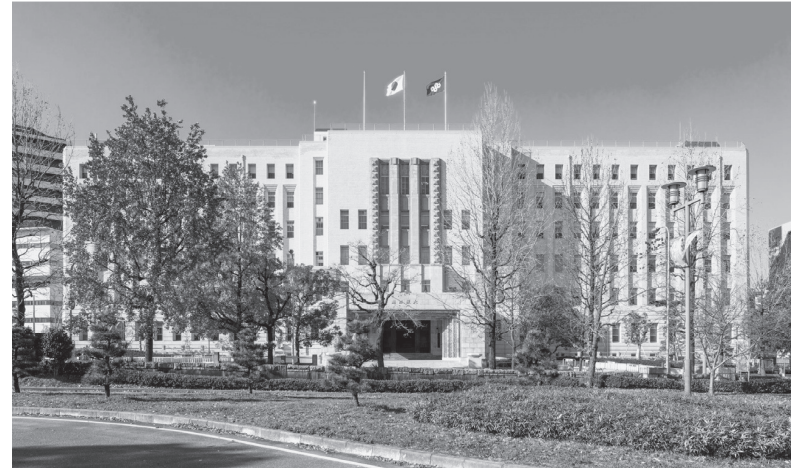
【大阪府庁舎本館環境改善その他工事】
