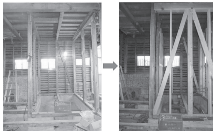
【耐震改修工事】
