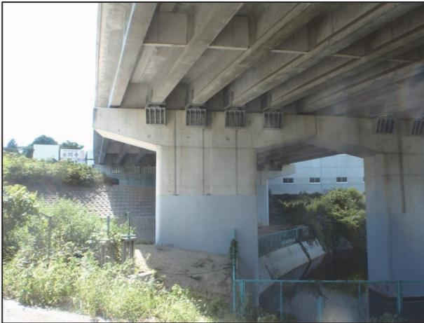
写真 4：国道 170 号 阿間河滝大橋 (耐震補強)
