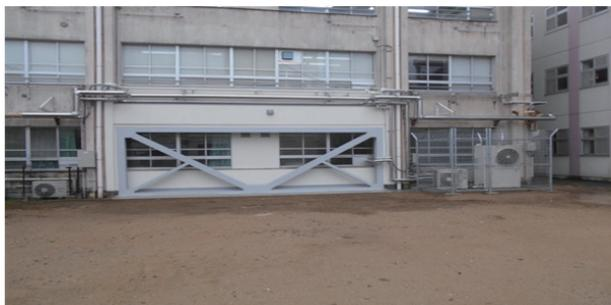
(写真3 非構造部材耐震改修 (体育館照明設備補強))
