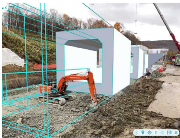
図5-5 省力化・省人化－施工管理での活用
