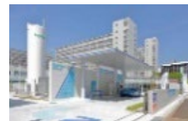
充電設備・水素ステーション整備
