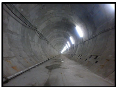
▲鶴見立坑～松生立坑の地下河川内部
