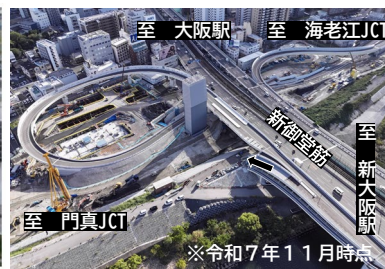
淀川左岸線（2期） 令和14年度完成予定
