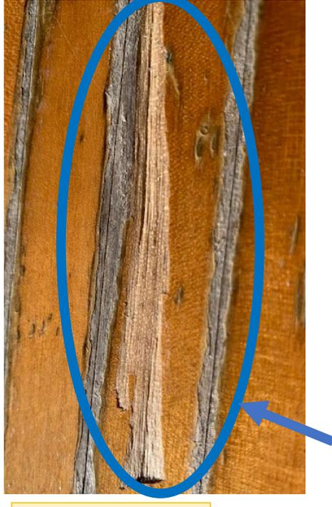
屋内運動場の床の破損（雨漏りが重なり、床が大きく剥がれた）
