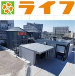
スーパーのライフの食品を加工・製造しているプロセスセンターで発生した生ゴミからバイオガスを発生させ、それを燃料に発電を行う施設。年間約4,380トンの食品廃棄物を削減し、年間の発電量は一般家庭約160世帯分の約70万kWhを見込んでおり、小売業では日本最大規模の設備。こちらを特別に見学させていただきます。
