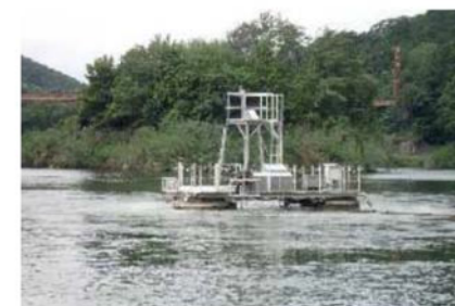
写真 5.1-2 浅層曝気循環設備（室生ダム） （出典：ダム等管理フォローアップ定期報告書）
