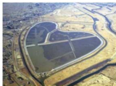
写真 5.1-3 干し上げ（渡良瀬貯水池） （出典：ダム等管理フォローアップ定期報告書）
